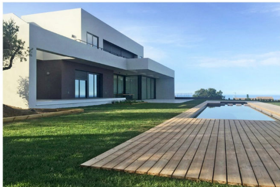
Maison à Begur (ES)
