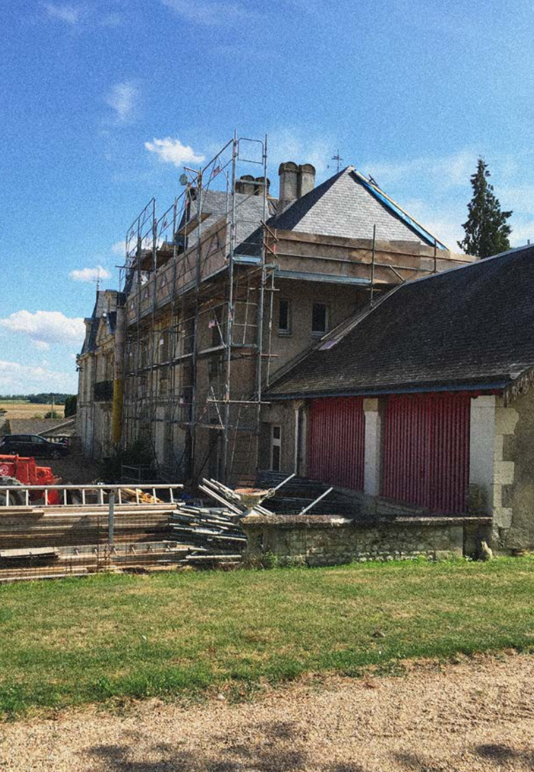
(16) 2018 renovation de la toiture
