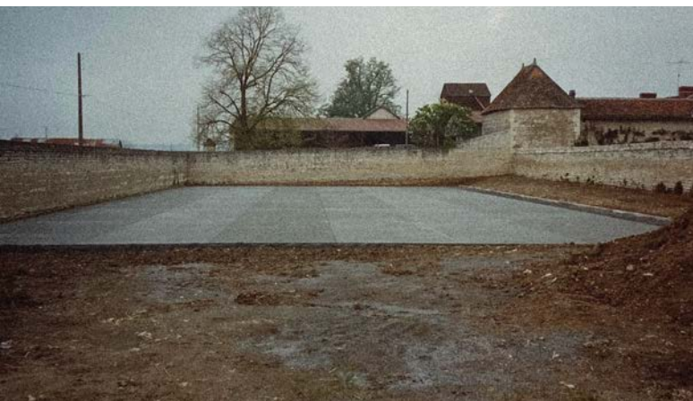
(7) 1991 construction du terrain de tennis
