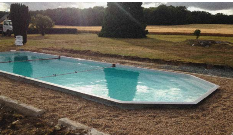
(19) 2017 renovation de la piscine
