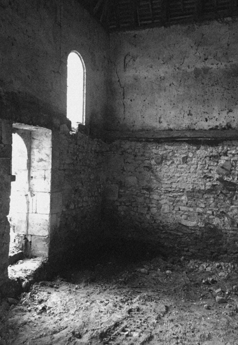
(17) 2021 renovation de la chapelle
